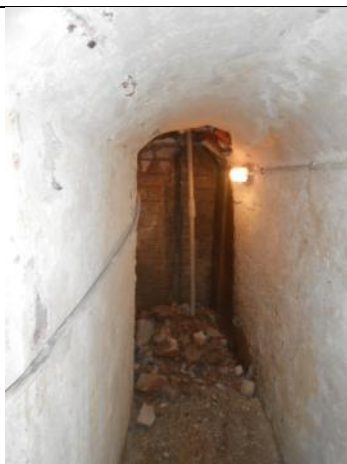
Foto 17 - Detall del muret U.E. 102 i l'estrat de calç U.E.103.
