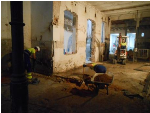
Foto 1- Pati de llums i Inici dels treballs de l'encepat 1.
