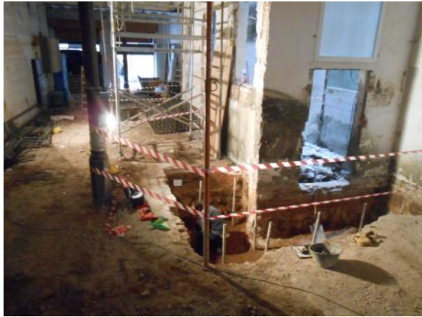
Foto 19- Inici dels treballs a l'interior del pati de llums.
