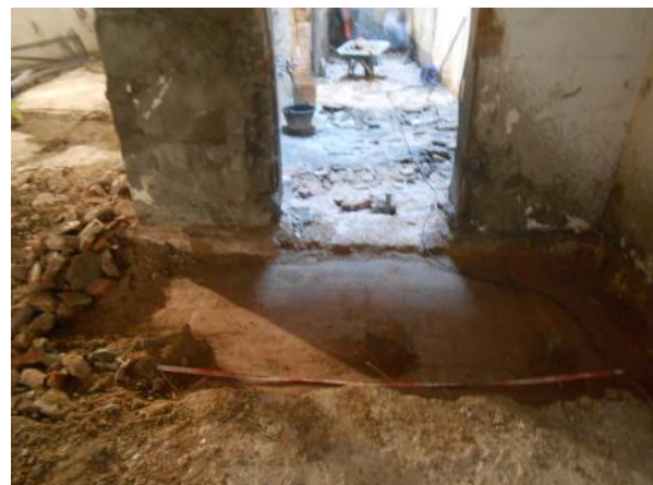
Foto 16- Muret de maons U.E. 102 i claveguera U.E. 105
