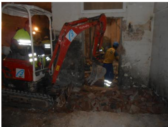
Foto 15- Inici dels treballs a l'interior del pati de llums.
