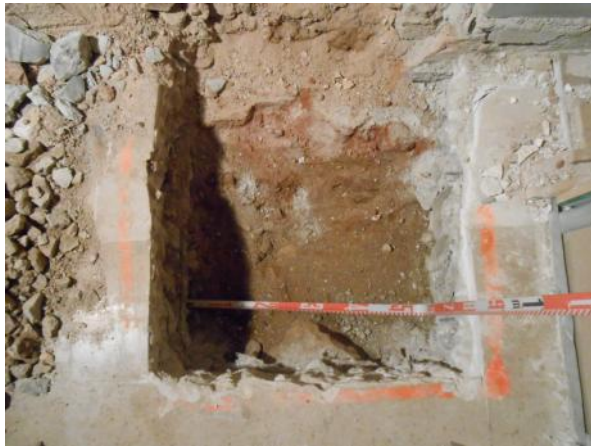
Foto 27 - Sabata 3A durant l'execució del sondeig. Banqueta del mur mitger U.E. 308.
