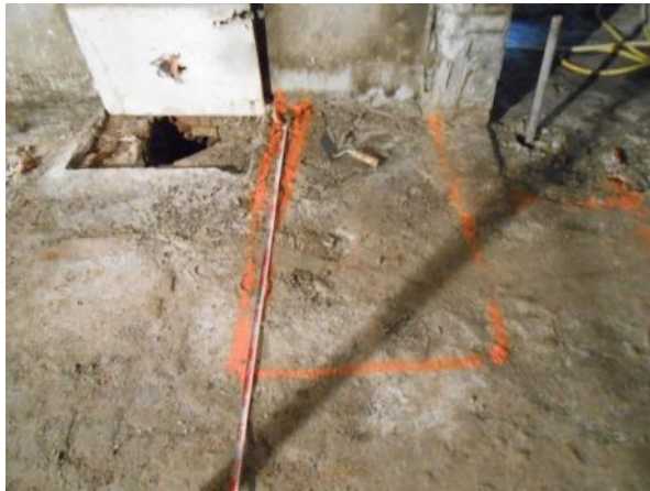
Foto 13- Pati de llums i inici dels treballs de l'encepat 1.
