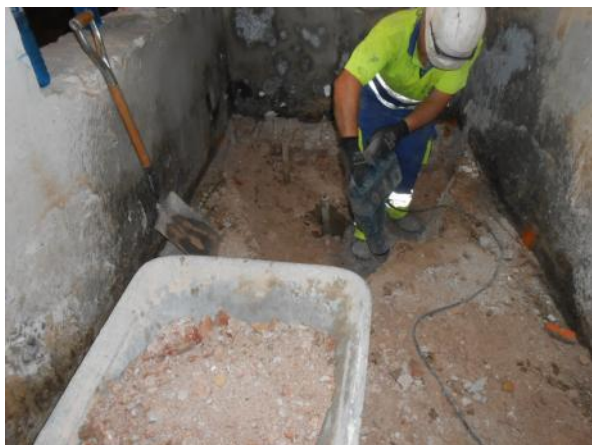
Foto 3- Inici dels treballs a l'interior del pati de llums.
